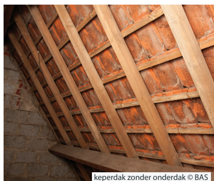
keperdak zonder onderdak © BAS
