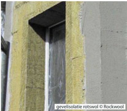
gevelisolatie rotswol © Rockwool
