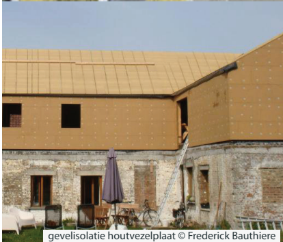
gevelisolatie houtvezelplaat © Frederick Bauthiere
